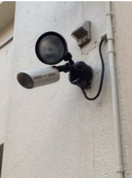
無線LANの設置
