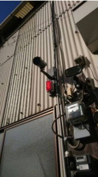
無線LAN工事
