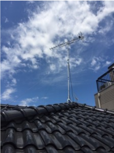
図1-2 Yagi-Udaアンテナの設置例
