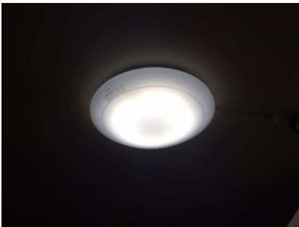
LED照明器具の設置方法
