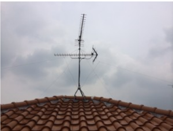
図1-2 Yagiアンテナの設置例
