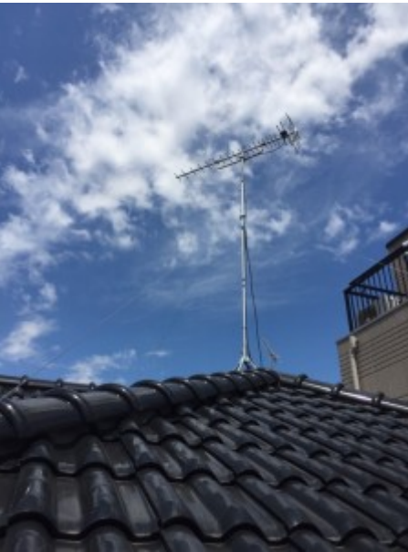
無線LANの設置場所（屋根上）
