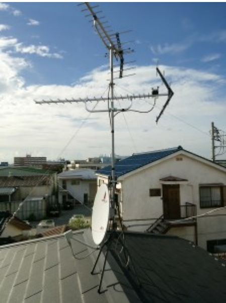
無線LANの設置とインターネット接続の準備
